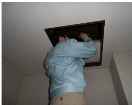
「小屋組・梁」調査の様子
