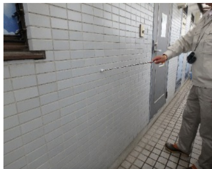
「外部（外壁）」調査の様子
